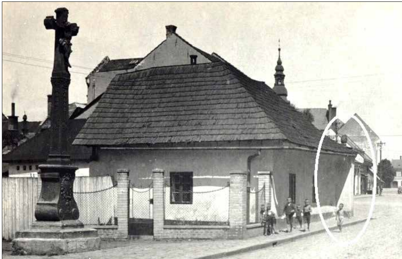
Obr. Pohled na severní pilíř Vyškovské brány směrem k náměstí.
