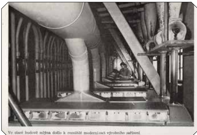
Ve staré budově mlýna došlo k rozsáhlé modernizaci výrobního zařízení
