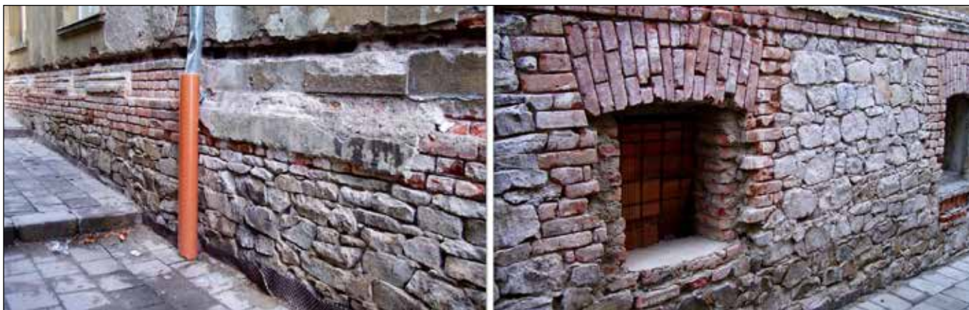
Obr. Hradební kameny v obvodové zdi bývalého pivovaru při jeho rekonstrukci v únikové uličce.
