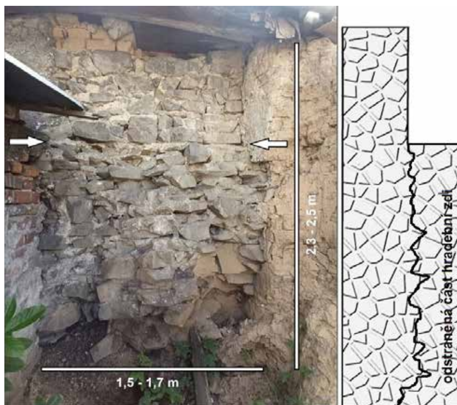
Obr. Přibližné rozměry fragmentu hradeb a nákres řezu fragmentem.
