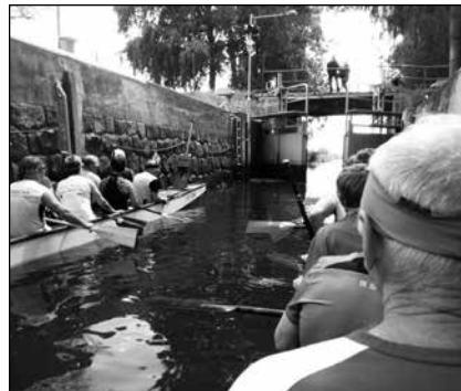
Plavební komora Spytihněv
