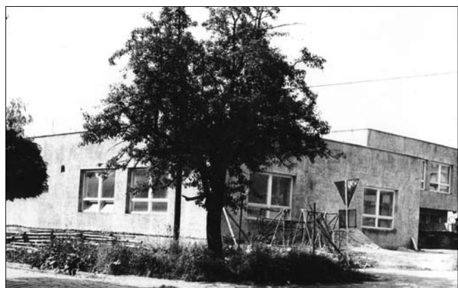
Stavba restaurace Morava
