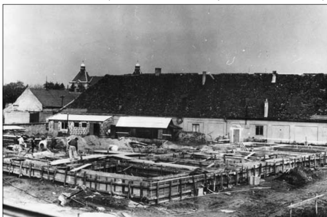
Stavební základy budovy Mateřské školy v Hanusíkově ulici, v pozadí bývalý Školní statek, nyní areál gymnázia
