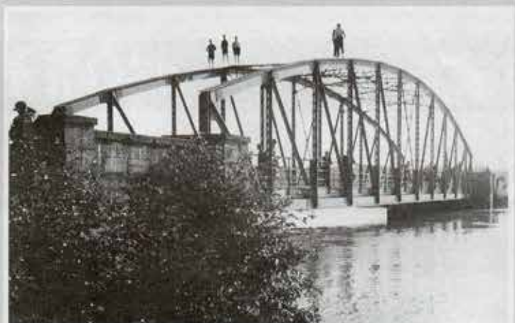
Silniční most přes Moravu na cestě k Chropyni. Do roku 1903 zde stával panský dřevěný most.
